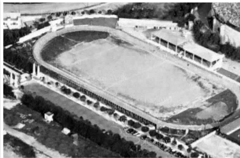
Una veduta aerea dello Stadio della Rondinella
