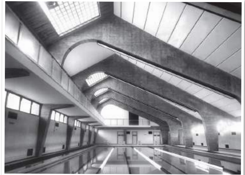
La piscina all'interno dello Stadio Flaminio
