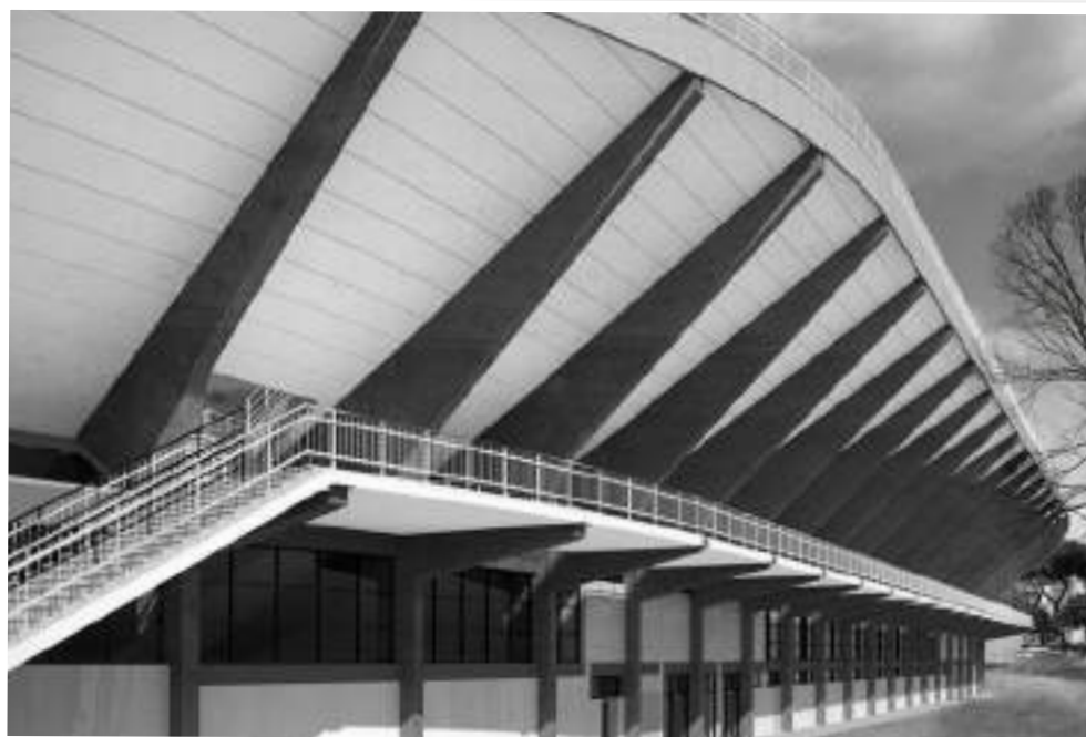
Veduta esterna della tribuna scoperta
